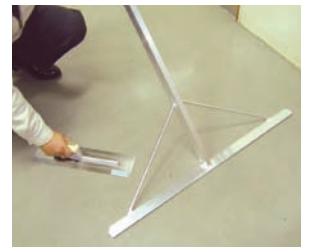
裏で頭張り作業
