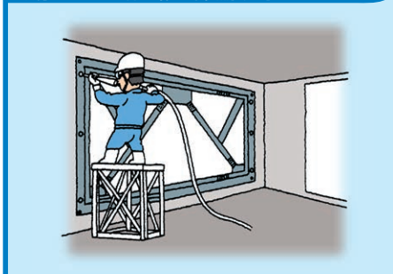
鉄骨ブレース、増壁(柱、梁)補強工事
